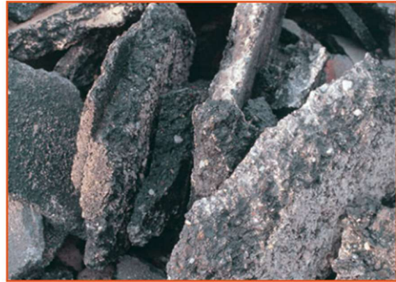
Belagsaufbruch (nur Kleinmengen)
